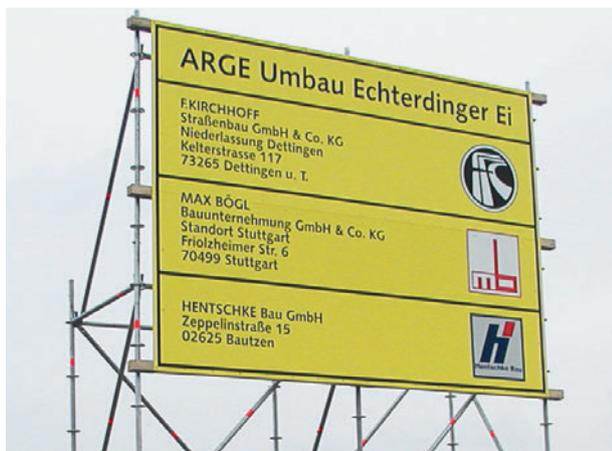
Det er hurtigt at samle stilladser til reklameskilte i henhold til diverse specifikationer, og skiltene tilpasses let til terrænet. Konstruktionen kan, afhængig af forholdene, stabiliseres ved hjælp af ballast eller ved at opsætte en grundsektion. Fastgørelse kan være både midlertidig og permanent.
